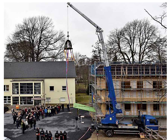
Die Richtkronen wird aufgesetzt.
