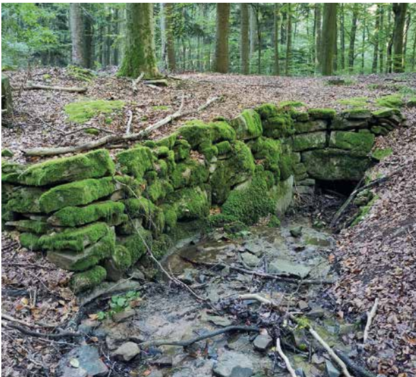
Zur preußischen Zeit im späten 19. Jahrhundert wurde der Alsberger Hang durch den Bau hangparalleler Wege für die Holzabfuhr besser erschlossen. Dabei entstand auch diese Kombination aus Stützmauer und Bachdurchlass im oberen Zimmergraben. Als Baumaterial wurde der vor Ort anstehende Buntsandstein verwendet.
