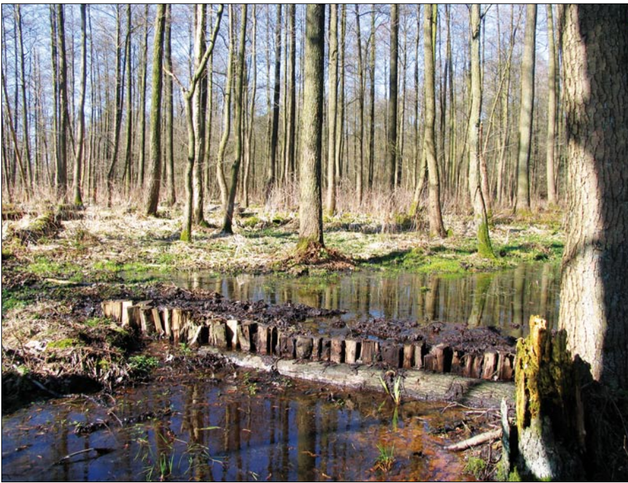
Abb. 3: Verschluss der Seitengräben im „Hörsten Bruch“
