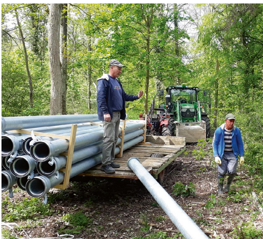
Bild 4: Anlieferung der Rohre für die Verteilerleitungen und Anordnung der Leitungen
