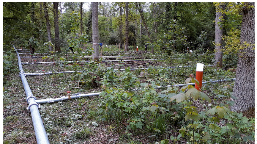
Bild 4: Anlieferung der Rohre für die Verteilerleitungen und Anordnung der Leitungen
