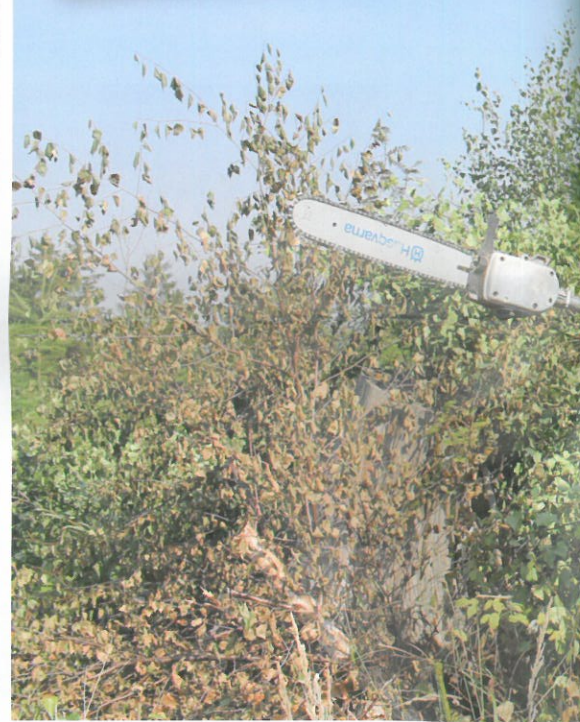
Abb. 4: „Space-Saw“ im Einsatz
