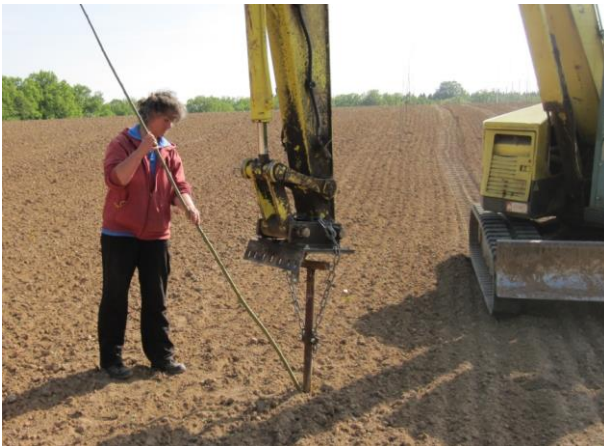
Abb. 3: Baggerpflanzung mittels Locheisenvorstecher bis 150cm Tiefe, anschließendes Einsetzen der Setzrute und verfüllen des Pflanzloches.
