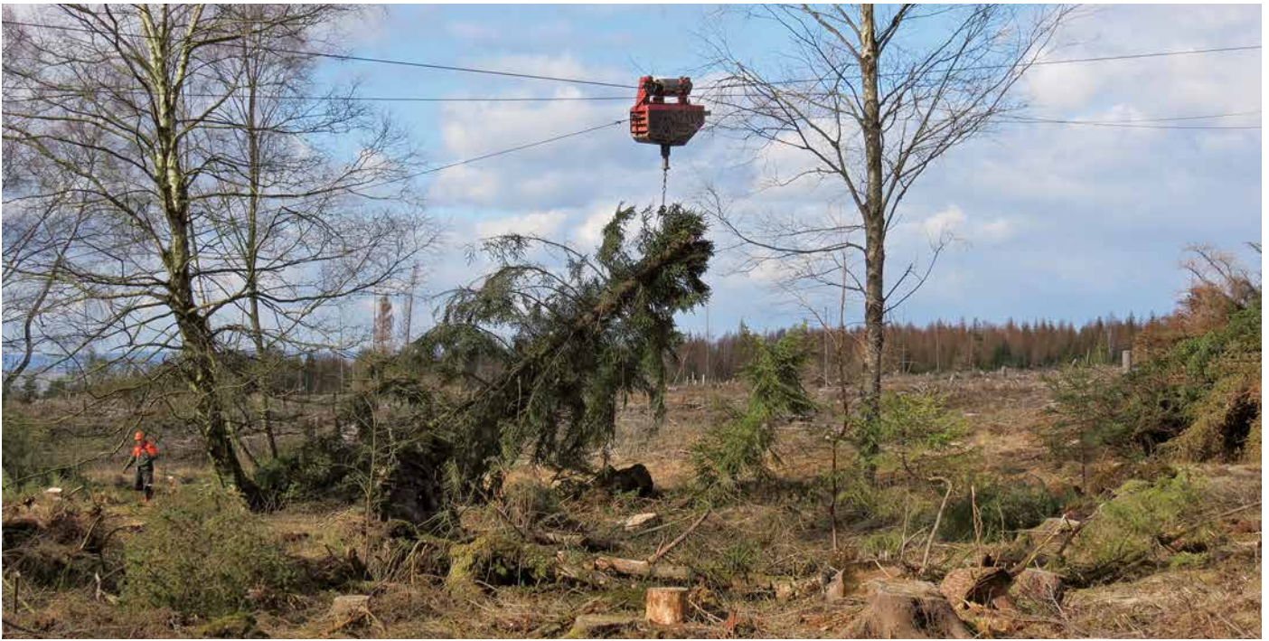
Bei der Entnahme von Nadelbäumen muss teilweise Seilkrantechnik eingesetzt werden, um die sensiblen Moorstandorte nicht zu beeinträchtigen. Ein lockerer Schirm von Moorbirken bleibt hier erhalten. Foto: M. Schmidt
