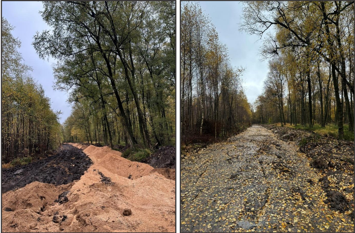
Abbildung 14: Eingebrahtes Sägemehl im Hauptgraben nördlich des alten Moorbirkenbestands (links). Mit organischem Material (Grabenaushub) abgedeckter Graben nach Ende der Arbeiten. Links der Baustraße befinden sich Monitoringflächen der Variante 4-1, rechts solche der Variante 0-0. Beide Varianten sind seit der Umsetzung der Maßnahmen bereits deutlich vernässt. Fotos: A. Wittenberg
