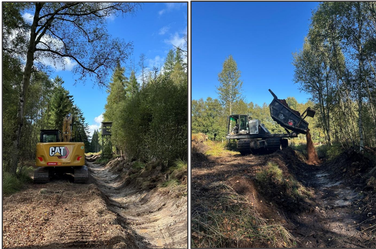
Abbildung 13: Grabensäuberung am Graben südlich des Kleinen Bruchs (links). Ein Dumper mit drehbarer Mulde kippt Sägespäne ab (rechts). Fotos: A. Wittenberg
