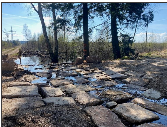
Abbildung 16: Furt aus Sandsteinblöcken am nordwestlichen Ablauf des Projektgebiets Wildenkiel Süd (links). Rückstaubereich mit Moor-Birken (rechts). Fotos M. Aljes.
