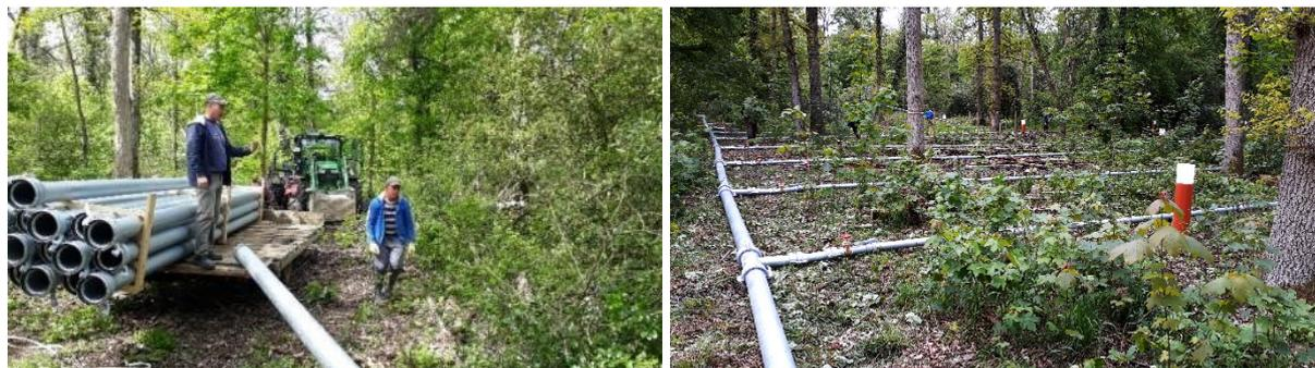
Abbildung 7: Anlieferung der Rohre für die Verteilerleitungen und Anordnung der Leitungen
