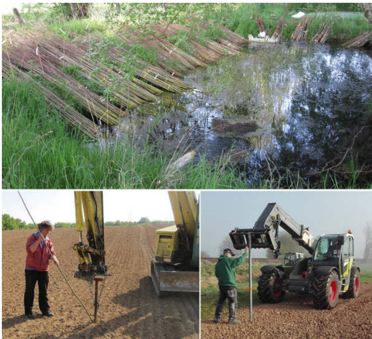
Abbildung 19: Oben zu sehen ist das Wässern der Setzruten kurz vor der Auspflanzung. Links unten ist das Stecken der Setzrute durch Baggerpflanzung mit Locheisen und verfüllen des Pflanzloches zu sehen. Rechts unten ist die im Zuge der Zusammenarbeit mit dem Landesbetrieb Landwirtschaft in Hessen (LLH) modifizierte Pflanzung zu sehen. Diese erfolgt durch eine an den Frontlader angebrachte Eisenstange/Rohr, die Markierung zeigt die Pflanztiefe an, hier 80 cm. Foto rechts unten: Christian Siebert.
