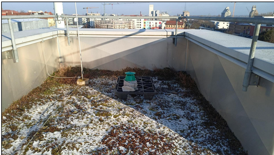
Abbildung 74: Testanordnung Freifeldtest auf dem Dach Fraunhofer Gebäude Sandtorstrasse
