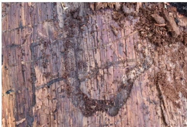
Abb. 19: Fraßgänge von Bockkäfern (Bildmitte) überprägen später teils die Prachtkäfergänge. Dieses Bohrmehl ist gröber und weniger fest gepresst, das Splintholz wird tiefer gefurcht.
